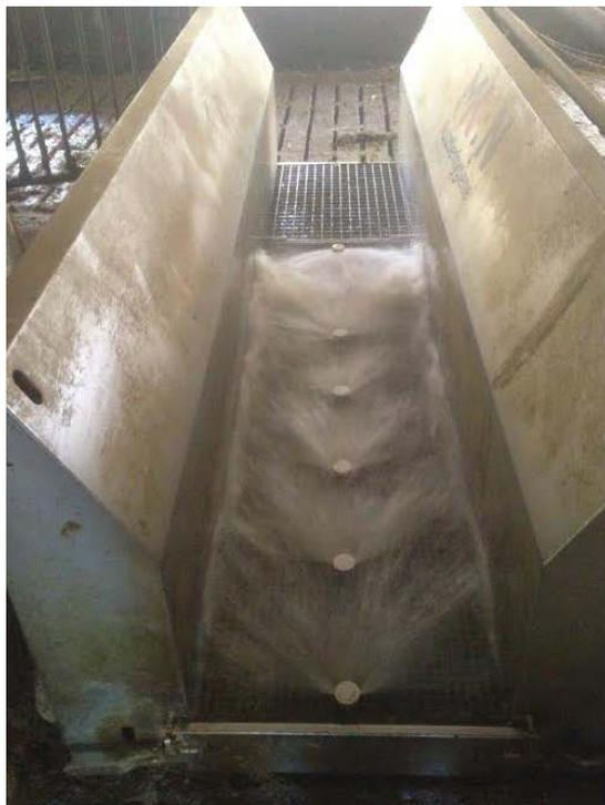
**Abbildung 6:** Klauenwaschanlage des Versuchsbetriebs
